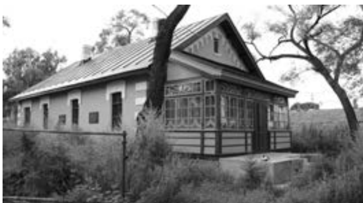
Кирпичный жилой дом после реставрации.
