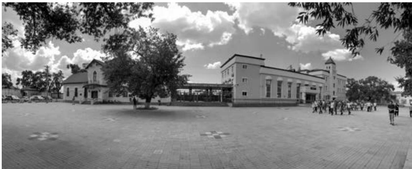
Площадь перед железнодорожным вокзалом на станции Аньанси: слева — современное здание, построенное на месте бывшего одноэтажного павильона; справа — двухэтажный павильон старого вокзала после реставрации. Август 2018 года.
