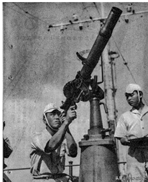
Тумбовая установка японского флотского зенитного пулемёта «Льюис».
